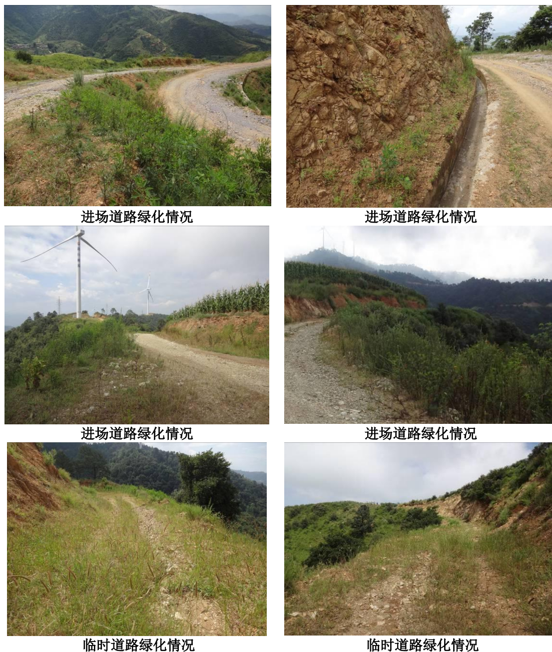
图 5.1-4 场内道路区植被恢复现状
