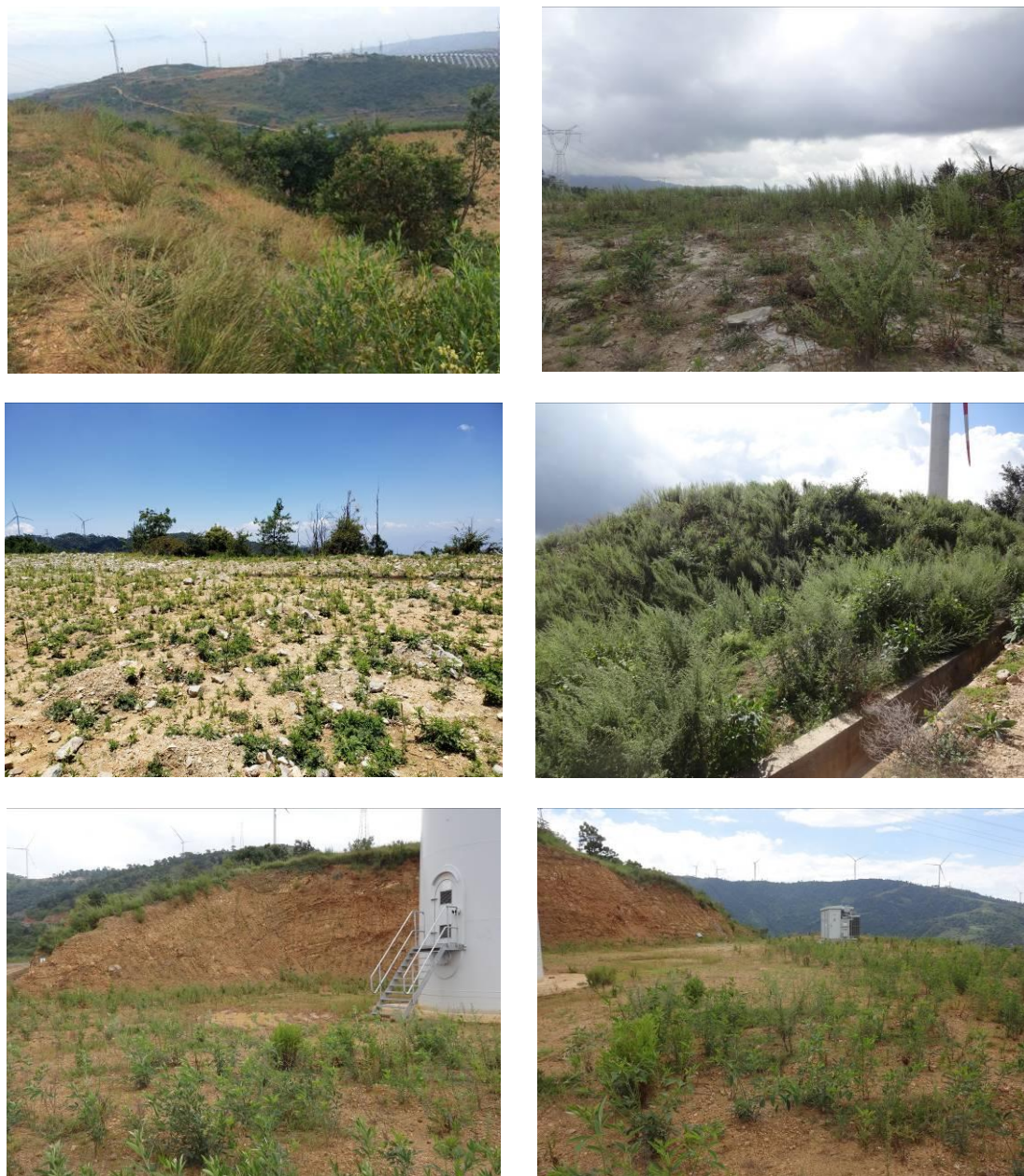
图 5.1-2 吊装平台区植被恢复现状图
